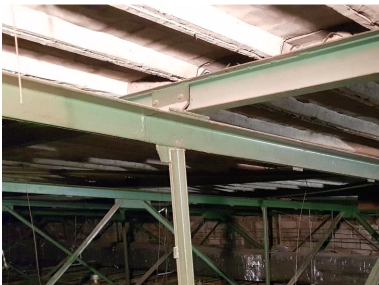
Widok węzła podporowego płatwii
