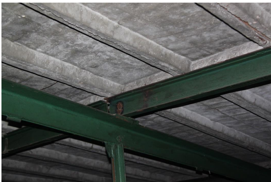
Przegubowe połączenie płatwi. Widoczne płyty korytkowe.
