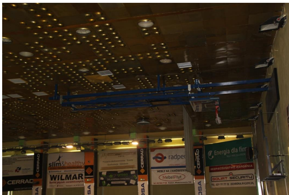
Widok sufitu od strony boiska. Widoczne oświetlenie. Na powierzchni sufitu widoczne zagniecenia blach. Efekt poruszających się w przestrzeni poddasza ludzi.
