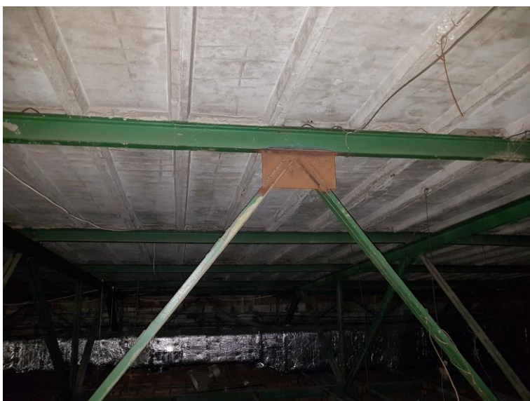
Widok układu płyt korytkowych – stan istniejący
