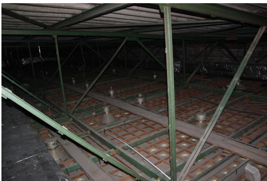
Konstrukcja sufitu podwieszonego. Widoczne usytuowane w sposób ortogonalny belki stalowe i podwieszony na stalowych wieszakach ruszt drewniany. W tle wyboczone krzyżulce i słupki dźwigarów.
