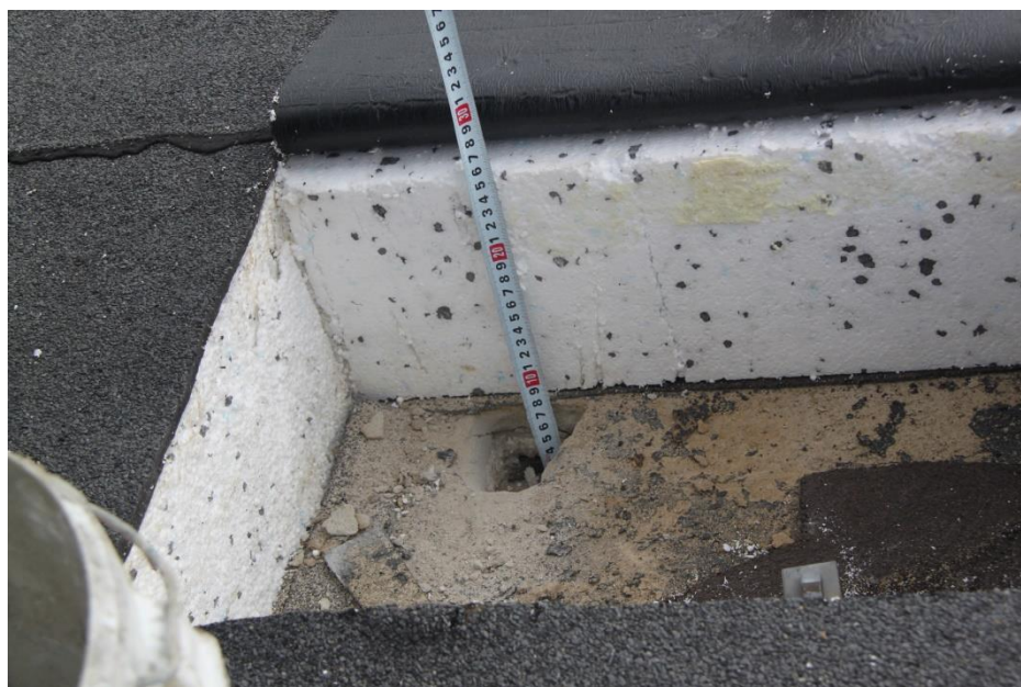
Odkrywka. Widoczne nowe i stare pokrycie.
